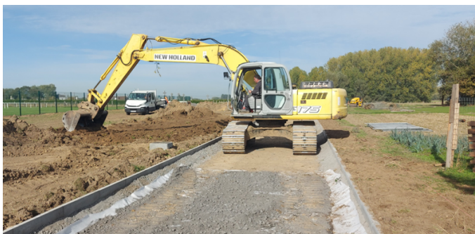
Préparation de la voirie d'accès
