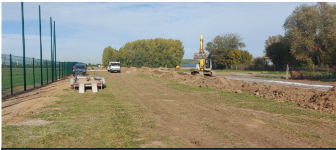
Installation des grilles de séparation avec le terrain de football
